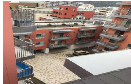
図7 市営大町復興住宅1号（釜石市）の外観（著者撮影）
