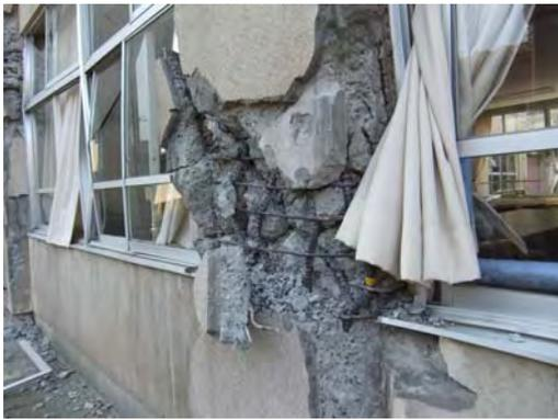
振動による柱のせん断破壊
