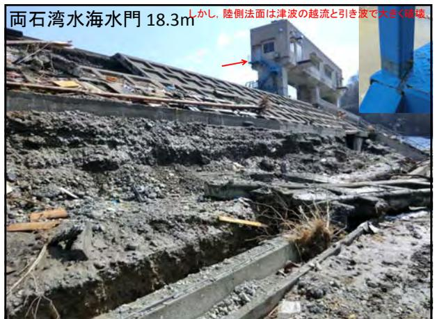
しかし、陸側法面は津波の越流と引き波で大きく破壊、
