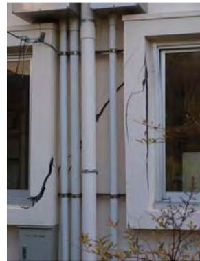
不同沈下による柱のせん断破壊
