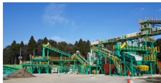
再生土製造プラント全景（提供元：一般社団法人再資源化研究機構）
