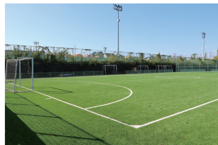
体育施設の改修(フットサル場)
