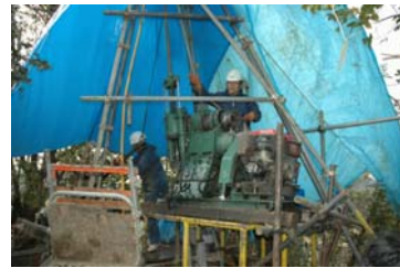
写真3. ボーリング調査
