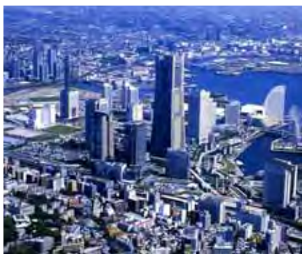
写真1 横浜みなとみらい地区周辺
