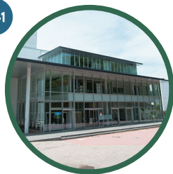
先進実践学環 学生センター
