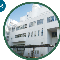
都市科学部・都市イノベーション学府 工学基礎研究棟
