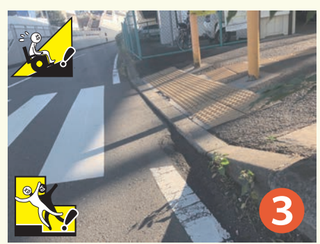
3 4 横断歩道と歩道の上に段差と傾斜が連続しています。
